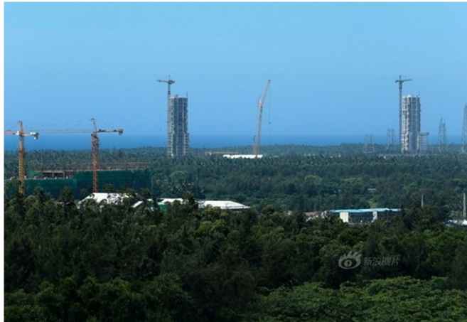
Arbetet med Kinas nya rymdhamn på ön Hainan är i full gång och raketmonteringsstorn sträcker sig redan mot himlen. Bild: China Space hemsida
