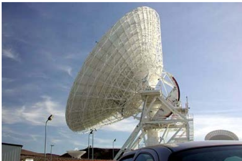
34-meters antennen i Goldstone med upp till 20 kW sändareffekt
